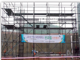
(MIR Steelでの公開施工デモの様子)
