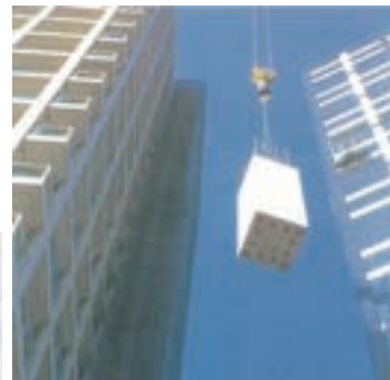
工場生産されたプレキャスト部材
