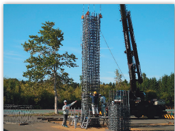
公開実験の様子（橋脚）
