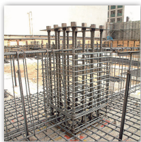
(アンカーユニット設置状況)
