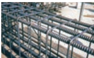
(せん断補強筋の配筋例)
