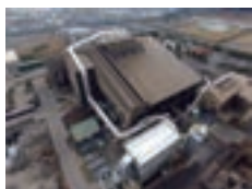
（更新後の建屋集塵機全景）
