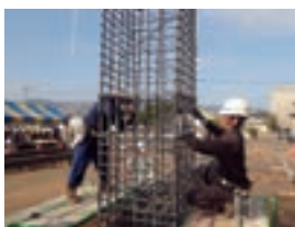
（公開実験施工状況）
