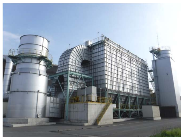
八戸工場 合流タイプの建屋集塵機
