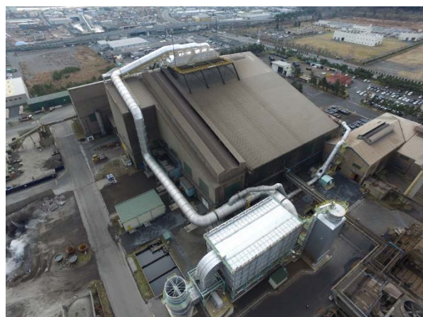
八戸工場 合流タイプの建屋集塵機
