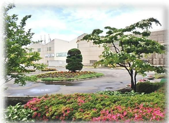
八戸工場 事務所前ロータリー
