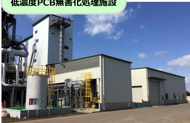
低濃度PCB無害化処理施設
