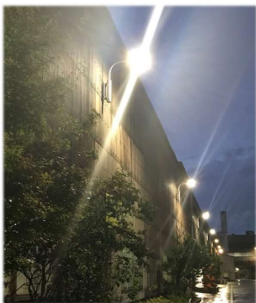
本社工場敷地内 外灯のLED化
