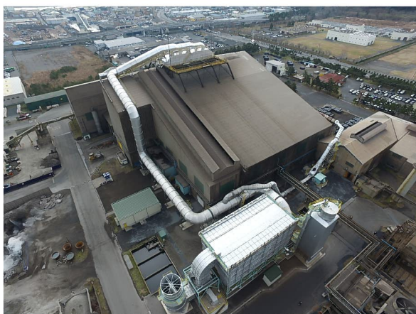
八戸工場 合流タイプの建屋集塵機
