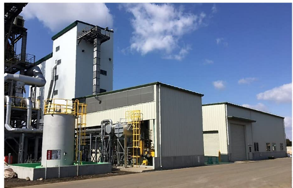
低濃度 PCB 無害化処理施設
